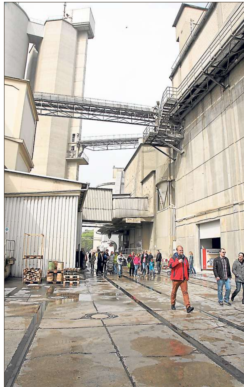
Zahlreiche interessierte Besucher nutzten den Tag der offenen Tür für einen Blick hinter die Kulissen.
